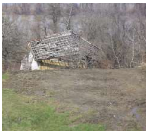
Слика 5 – Кућа срушена услед клизања Figure 5 – A house that collapsed due to landslide
